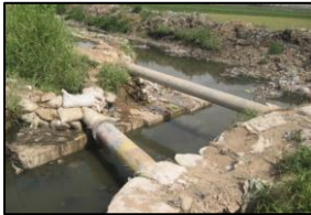
Eaux usées domestiques brutes- maraîchage Tabriz, IRAN
